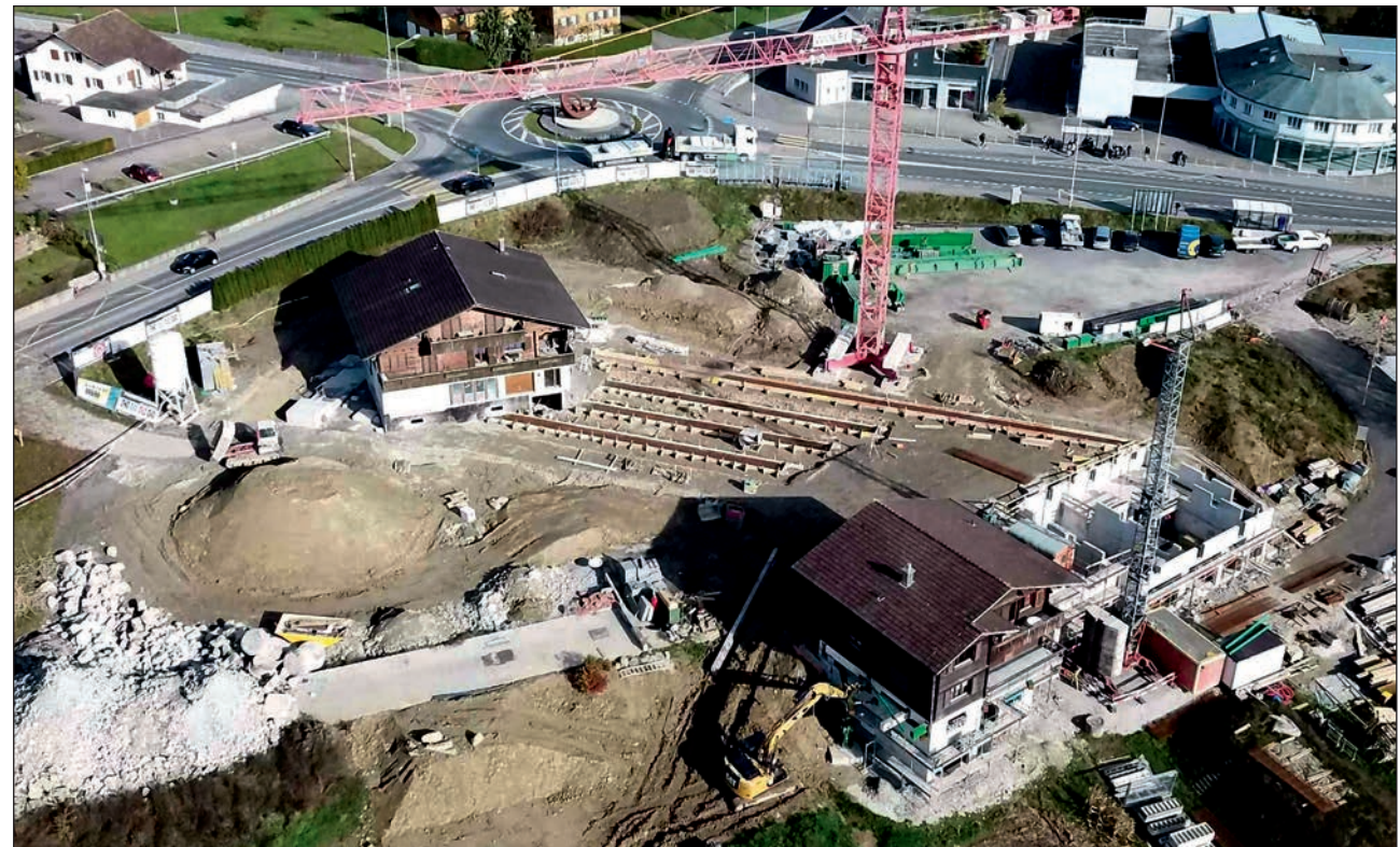
Um die Gewerbefläche optimal zu nutzen, wurden zwei Wohnhäuser bis zu 50 Meter verschoben.
